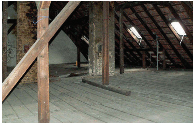
Abb. 3.1: Dieser zugängliche und begehbare Dachraum muss nach der neuen EnEV bis Ende 2011 gedämmt werden. Ob eine Dämmung des Daches oder der obersten Geschossdecke ausgeführt wird, bleibt dem Eigentümer überlassen.
