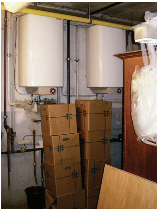
Abb. 4.4: Warmwasserbereitung mit zwei 80-Liter-Warmwasser-Speichern in einem Gemeindezentrum – hier sollte aus zwei Gründen dringend saniert werden: Erstens hat sich über die Jahre die Nutzungsstruktur stark verändert, sodass das vorhandene Warmwasservolumen mittlerweile erheblich überdimensioniert ist. Zweitens verfügen die Warmwassererzeuger über keine Temperaturregelung – der Legionellen-schutz ist also nicht gewährleistet. Es ist zu erwarten, dass sich die Betriebskosten durch die Umrüstung auf dezentrale Durchlauferhitzer spürbar senken lassen.
